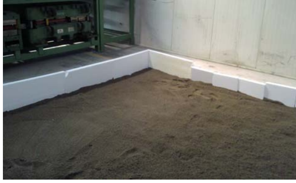
Şekil 2. Pres temeli ile fabrika temeli ayrımı
