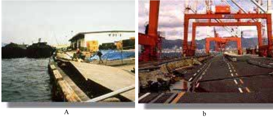
Şekil 1. Sıvılaşma Örnekleri. a) Dayanma yapısındaki göçme ve yanal yayılma, Kobe 1995 b) Rıhtım yapısının yanal ötelenmesi, Port Island, Kobe 1995 ( www.ce.washington.edu )
