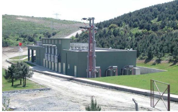
Şekil 8. İstanbul Hasdal Enerji Üretim Tesisi
